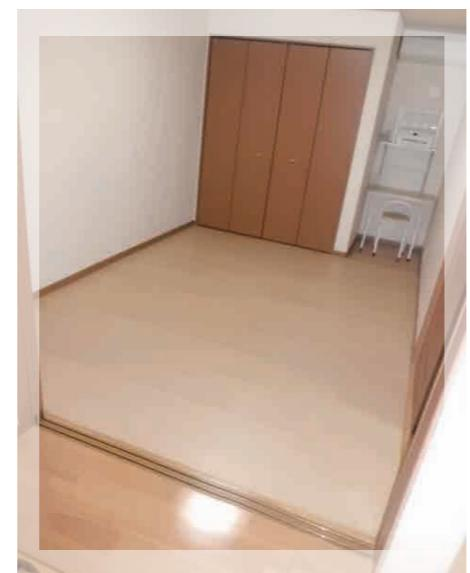
畳からフローリングへ変更しました。これで車椅子での移動がスムーズに行えます。
