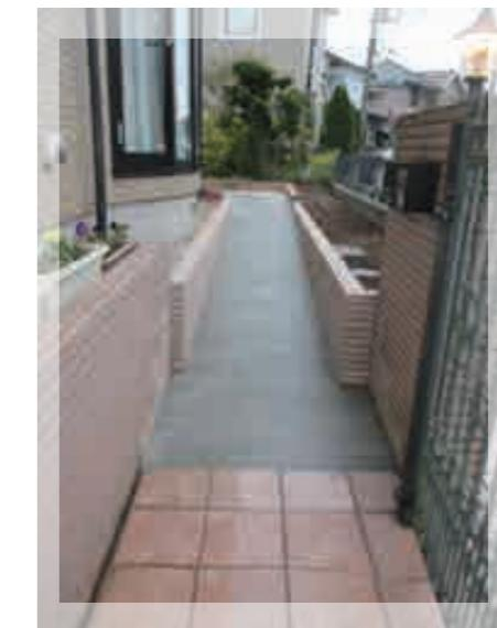
掃き出し窓から車椅子で出入りができるように、庭のスペースを使いスロープ土間打ち工事を行いました。スロープの距離を長く設けられたので、傾斜が緩やかになり、車椅子を押す介助者の負担の軽減に繋がっています。
